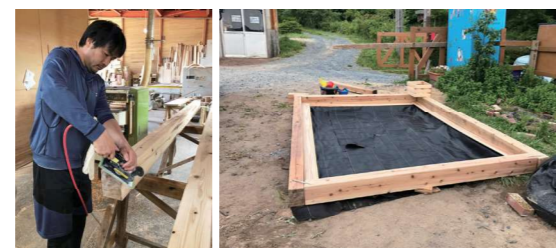
砂場の木枠(株)さかもとでカットし、現場に設置
